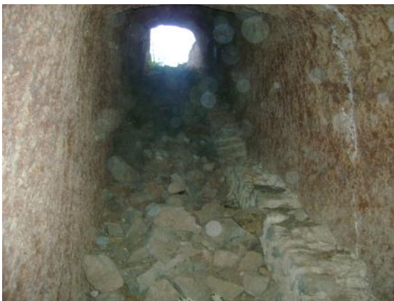
Refugio mina "sur", con entrada por el sur y sala hacia la izquierda.
